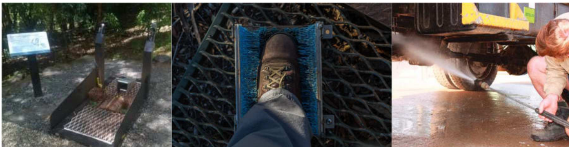
Figure 3 – Exemple de poste de nettoyage des chaussures à installer à l'entrée de la piste d'accès, et lavage du châssis de véhicule (sources, de gauche à droite : Queensland Government, http://hikingfiasco.com , South Coast Natural Resource Management)
