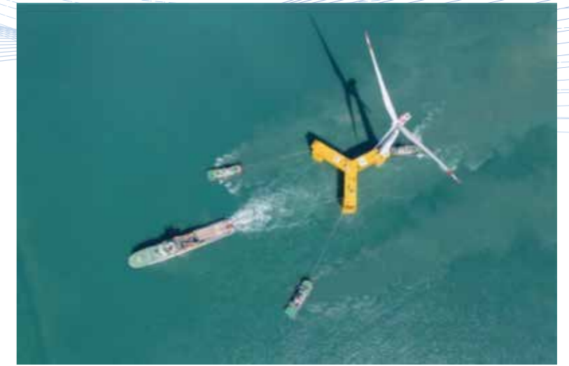
Figure 6. Installation en Chine de la première éolienne flottante résistante aux cyclones (07/2021)
