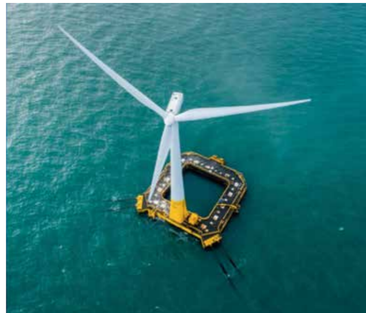
Figure 4. En haut : Semi-submersible, acier. Source : Principal Power En bas : Barge en béton. Source : Idéol
